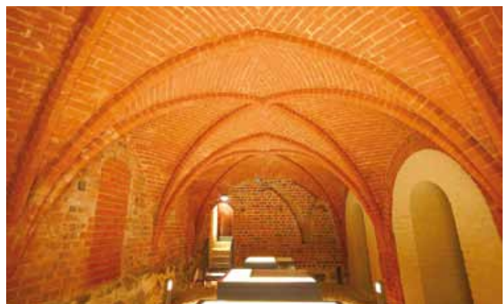
Klosteranlage mit mittelalterlichem Ursprung – noch deutlich zu erkennen im Kreuzgang
